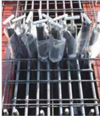
보용 분리타설재 설치 사례 Installation of Beam division placement material
