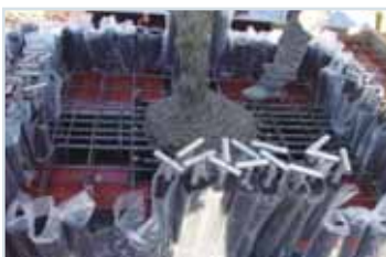
고강도 콘크리트 타설 High Strength Concrete Placement
