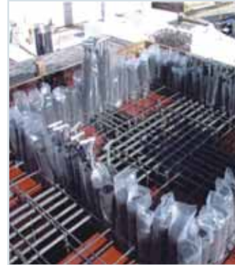
슬라브용 분리타설재 설치 사례 Installation of Slave division placement material
