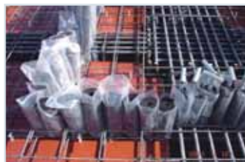
슬라브 콘스탑 설치 Installation of Slave Hi Con Stop
