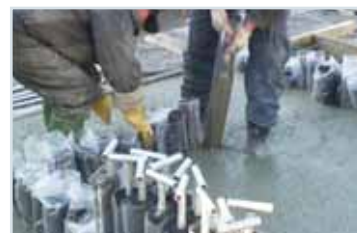
콘스탑 제거 Disassemble Hi Con Stop
